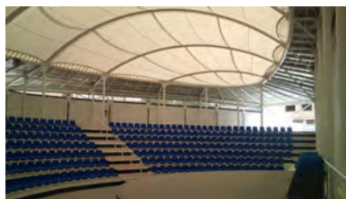
[Fig. 10] Auditorio Municipal, Gines (Sevilla). J.C. Gómez de Cózar y S. Bermejo Oroz. Malla compuesta por arcos continuos paralelos de curvatura idéntica y barras transversales de unión.
